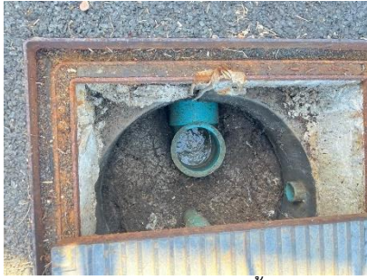
บ่อพักน้ำก่อนเข้าสู่ระบบระบบบำบัดน้ำเสีย ชุดที่ 1 (ฝั่งเหนือ)
