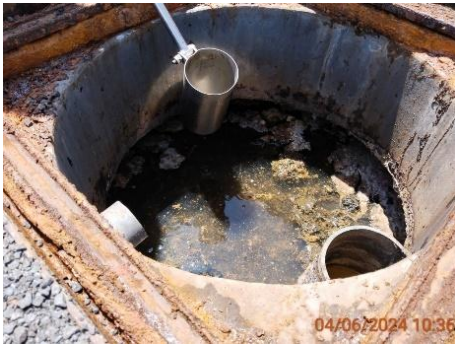
บ่อพักน้ำก่อนเข้าสู่ระบบบำบัดน้ำเสีย ชุดที่ 2 (ฝั่งใต้)
