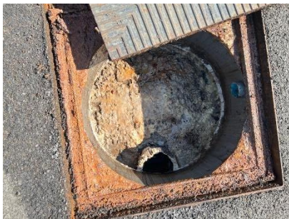
บ่อพักน้ำก่อนเข้าสู่ระบบระบบบำบัดน้ำเสีย ชุดที่ 2 (ฝั่งใต้)
